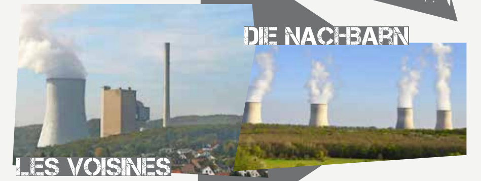
Centrale thermique de Bexbach et la centrale nucléaire de Cattenom. Et qu'en pensent les riverains ?
