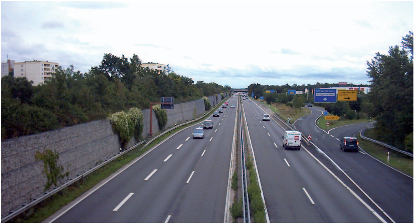
Gabionenwand als Lärmschutz an der B9
