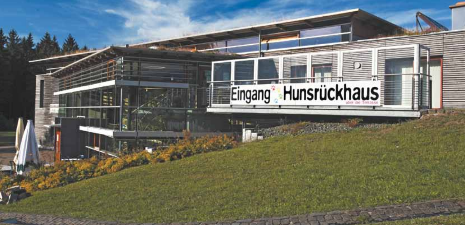
Zukünftiges NLP-Tor Hunsrückhaus am Erbeskopf
