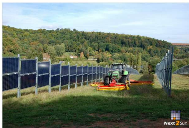
Abbildung 20: Photovoltaik-Freiflächenanlage mit bifacialen Modulen (Solarzaun) und landwirtschaftlicher Nutzung (Quelle: www.next2sun.de , abgerufen am 19.01.2023)
