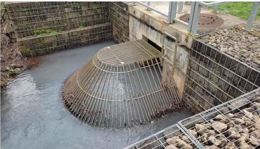
Beispiel für ein dreidimensionales Einlaufbauwerk
