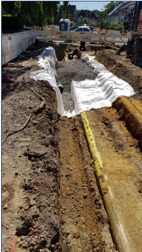
Abb. 18: Rigolenabschnitt neben Versorgungsleitungen
