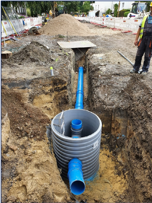
Abb. 22 u. 23: Drosselschächte erhöhen die Einstauleistung im Strang
