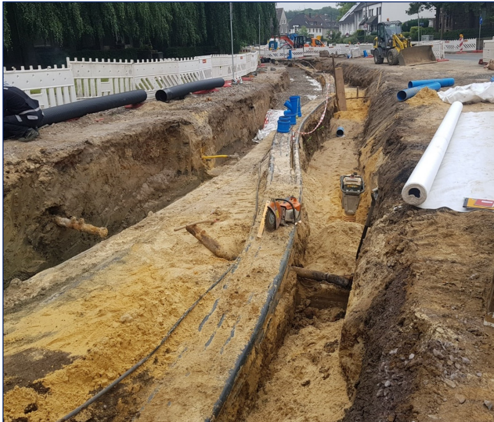
Abb. 16 u. 17: Rigolenabschnitt mit Bypass
