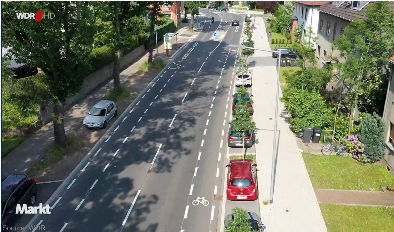
Abb. 30: Fertiggestellte 18 vernetzte Baumrigolen Wasserstr.
