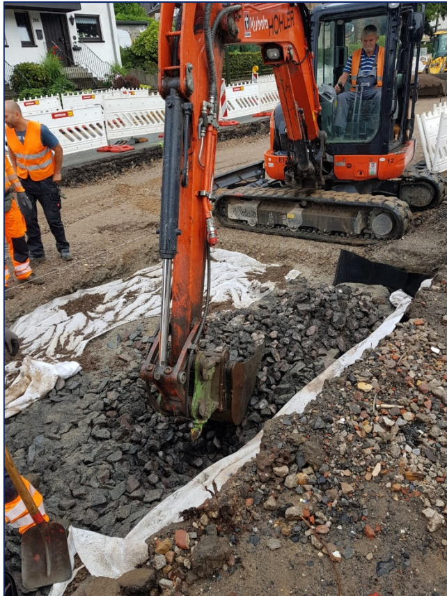
Abb. 24: Pflanzgrube der Baumrigole ca. 12 m 3
