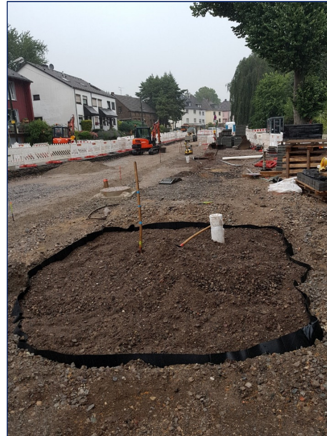
Abb. 25: fertig gestellte Baumrigole
