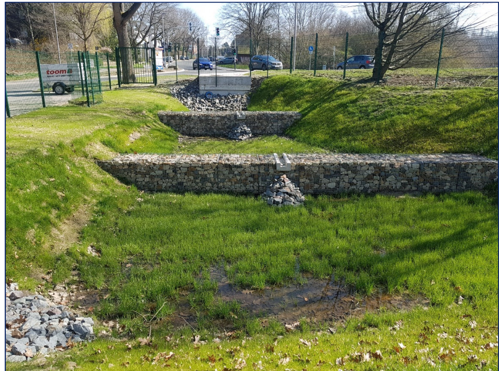
Abb. 28 u. 29 : Fertiggestellte Baumrigole u. Regenrückhalte- / Verdunstungsbecken
