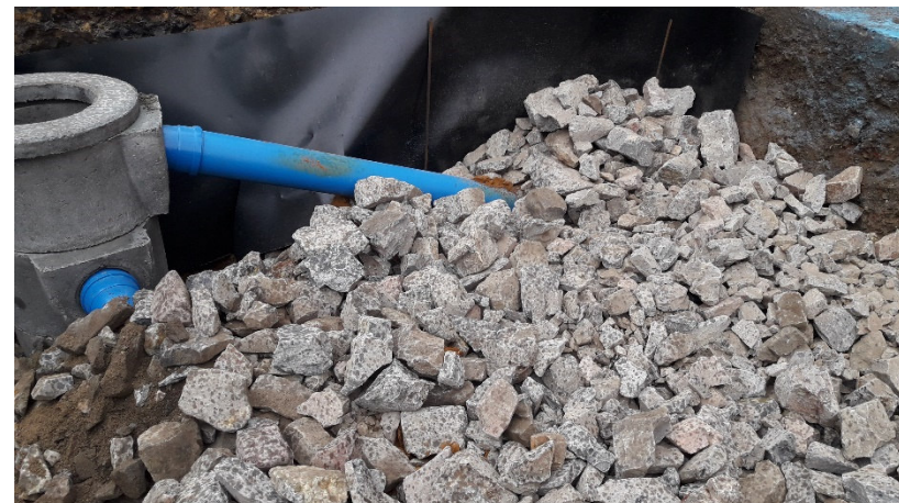
Abb. 4-7: Herstellung der Pflanzgruben der Baumrigolen Normannenstr.
