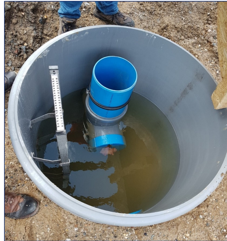
Abb. 22 u. 23: Drosselschächte erhöhen die Einstauleistung im Strang
