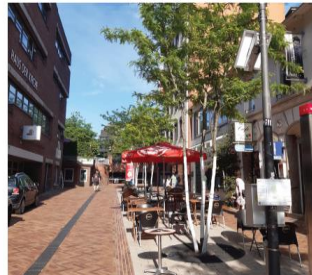
Abb. 87 - Schematische Darstellung der Baumrigole (ore.) [2], Einbau der Messtechnik (ure.) [22], Blick auf die fertiggestellten Baumrigolen (uli.) [22]
