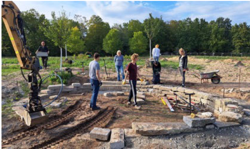
Erste Mitmachbaustelle – 24.09.22 - Foto S. Meier
